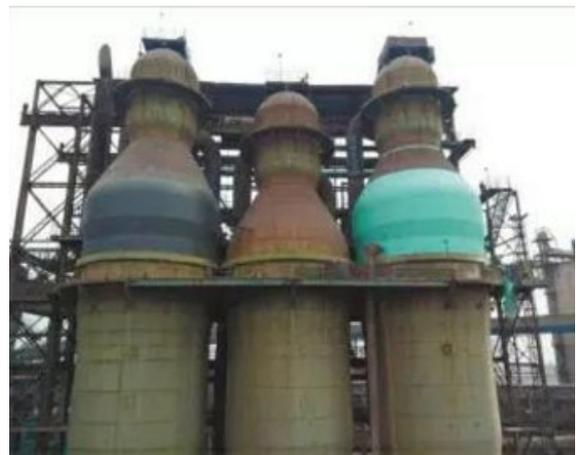
“热风出口独立膨胀段”热风炉和常规顶燃式“热风炉（引自附录〔2〕）
