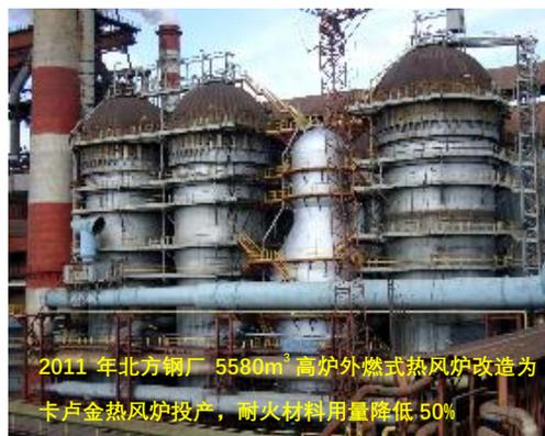
造工程中就采用了卡卢金 20 毫米孔径 (37 孔) 格子砖热风炉，耐火材料用量降低 50% (相比原外燃式热风炉)。
