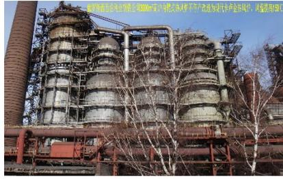
内燃式热风炉改造为卡卢金热风炉
