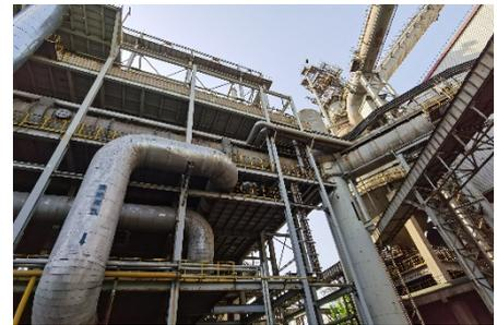
改造后顶燃式热风炉使用新管道，改造前内燃式热风炉仍然使用旧管道。
