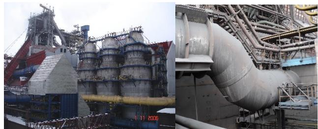
俄罗斯下塔吉尔钢铁公司 6 号高炉（2200m<sup>3</sup>）内燃式热风炉停产整体改造为卡卢金热风炉，热风主管采用斜管形式与原管道连接
