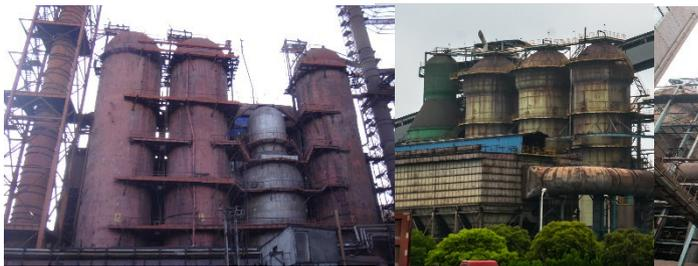
内燃式热风炉改造为卡卢金热风炉
