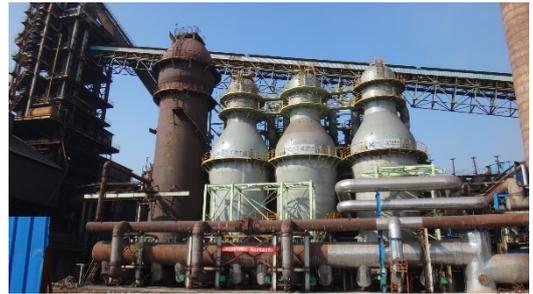
马鞍山 907m<sup>3</sup>高炉内燃式热风炉不停产改造为卡卢金热风炉，改造后风温提高到 1200℃，故障率降低
