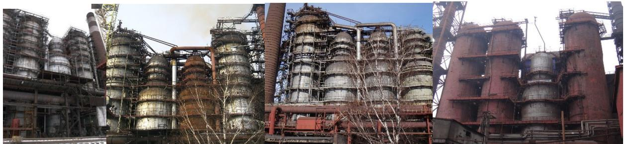
俄罗斯西西伯利亚钢铁公司 1 号高炉（3000m<sup>3</sup>）内燃式热风炉不停产改造为卡卢金热风炉
