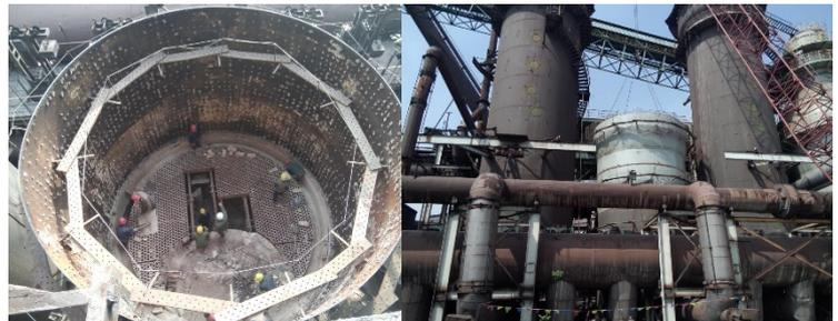
内燃式热风炉改造为卡卢金热风炉，下部直段炉壳利旧，基础好管道利旧
