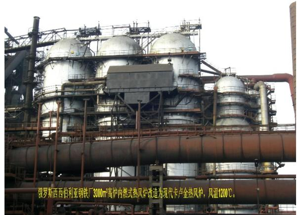
现代卡卢金热风炉与早期顶燃式热风炉对比，主要进步包括：
