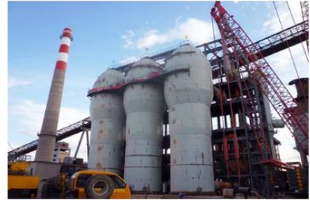
中国建设的“大帽子”顶燃式热风炉
