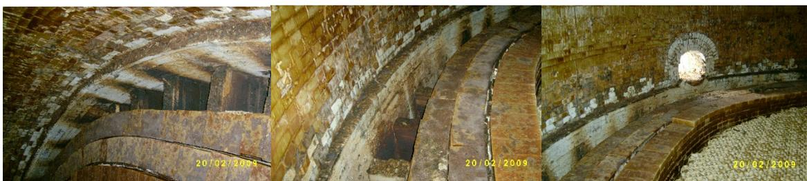
下塔吉尔卡卢金顶燃式热风炉运行 27 年的燃烧器和格子砖
