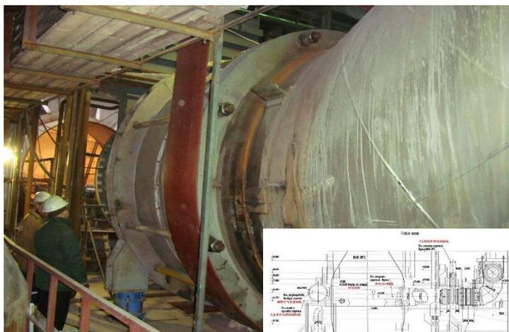
图 11 俄罗斯北方钢厂 5580m<sup>3</sup>高炉外燃式热风炉 1986 年投产，采用“U”形热风支管
