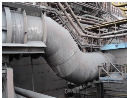
图 5 下塔吉尔 2200m<sup>3</sup> 高炉热风管道，稳定运行 13 年
