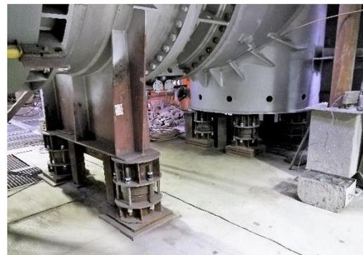
图 14 俄罗斯下塔吉尔 2200m<sup>3</sup> 高炉卡卢金热风炉采用“U”形热风支管，热风支管垂直段下部采用弹簧支座取代补偿器
