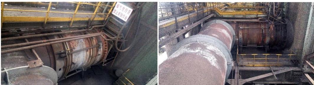
图4 云南 2000m<sup>3</sup>高炉内燃式热风炉热风支管和主管(2000年搬迁引进),补偿器位于热风阀和热风管道之间,无支管拉杆,无主管拉杆
