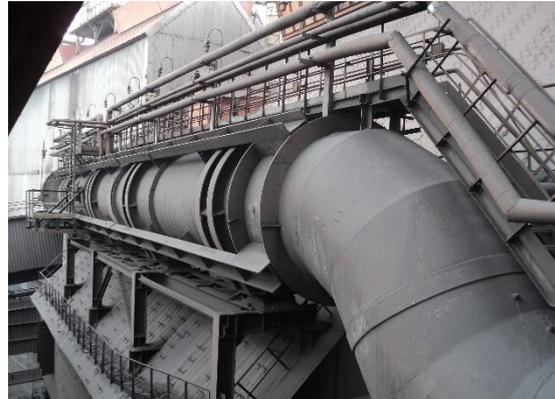
图 15 热风主管梁式拉杆 (俄罗斯下塔吉尔钢铁公司)
