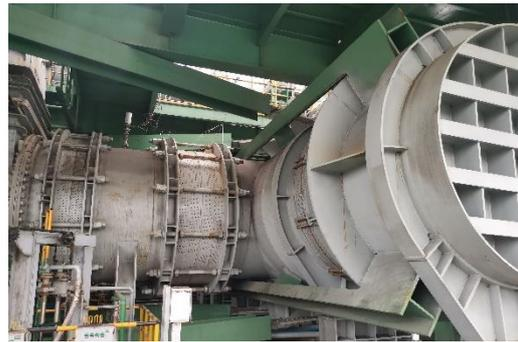
图 16 河北 5500m<sup>3</sup>高炉卡卢金热风炉热风主管梁式拉杆
