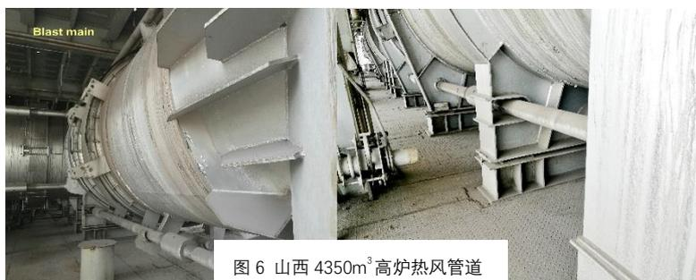
图 6 山西 4350m<sup>3</sup> 高炉热风管道
