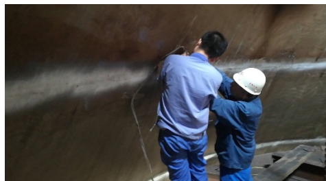
图 6 对 5500m 3 高炉热风炉现场炉壳焊缝进行残余应力检测
