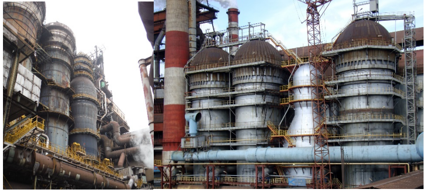
图 4 日本 JFE4300m 3 高炉库伯式外燃式热风炉改造为卡卢金热风炉
